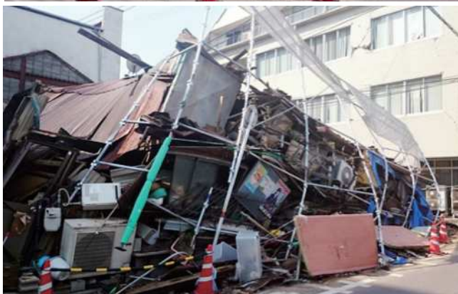
▲熊本市内の様子。古い木造建物の多くは破壊されている
